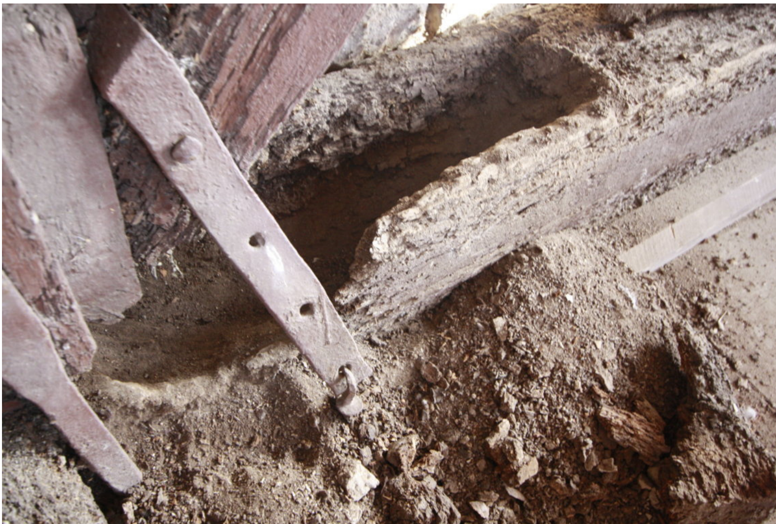
Trave del telaio ligneo settecentesco delle campane corrosa dalle infiltrazioni di acqua meteorica - Gennaio 2014
