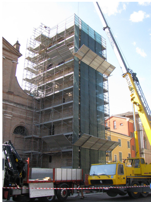
Lo smontaggio del concerto campanario - Luglio 2012 Ditta Capanni – Castelnuovo né Monti
