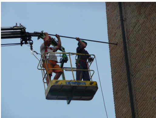
Inserimento d'urgenza di catene - Giugno 2012 Ditta UNIECO
