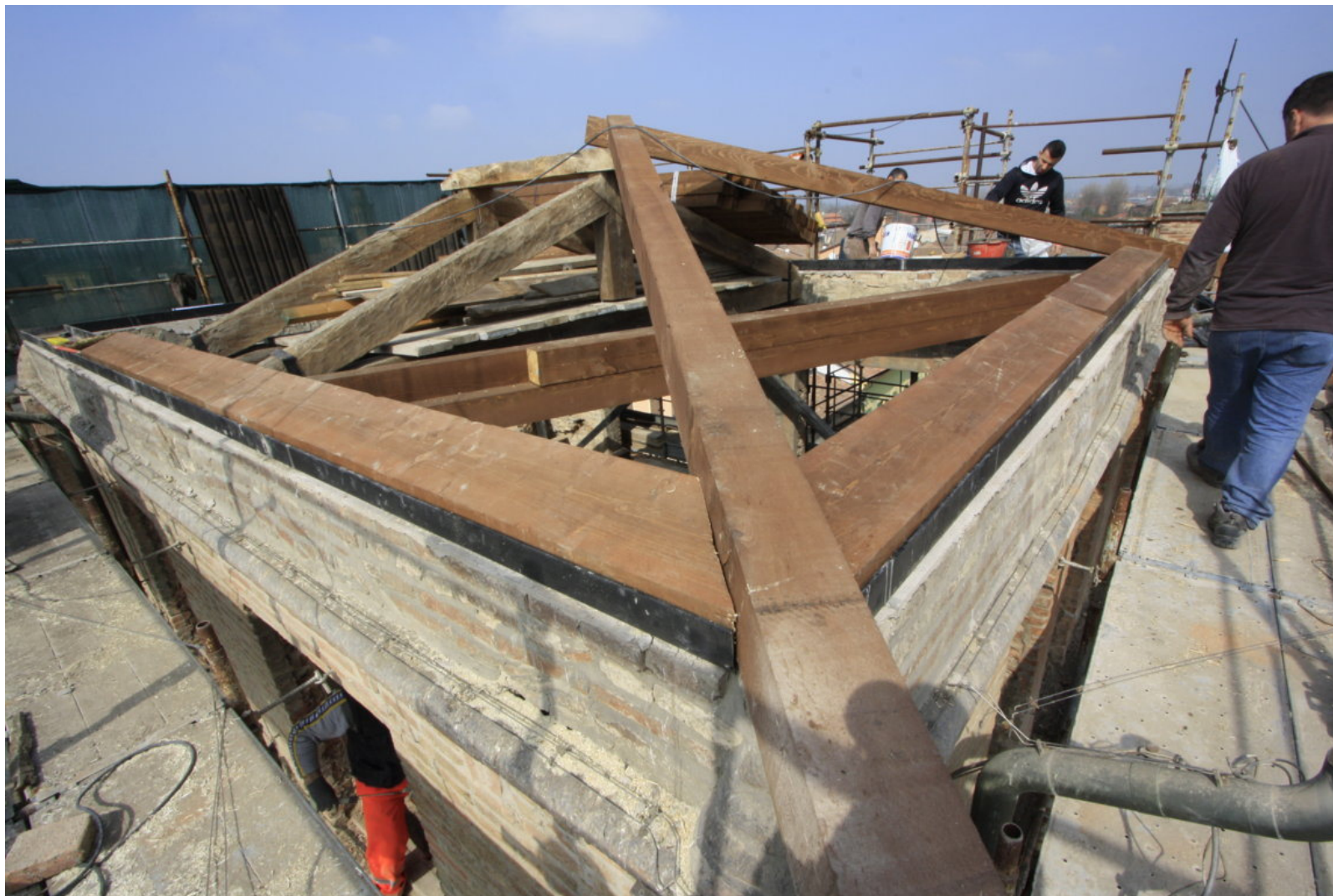
Fissaggio del cordolo metallico – ligneo di copertura - Marzo 2014
