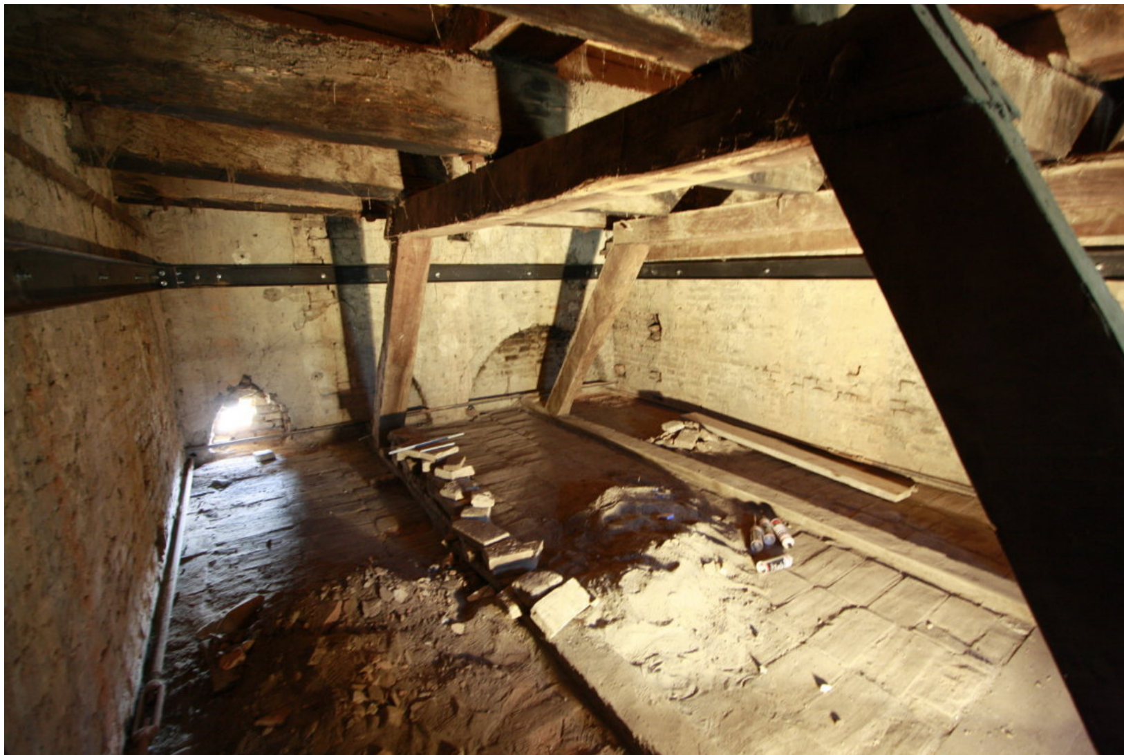
Cerchiatura interna nel piano sotto la cella campanaria - Marzo 2014
