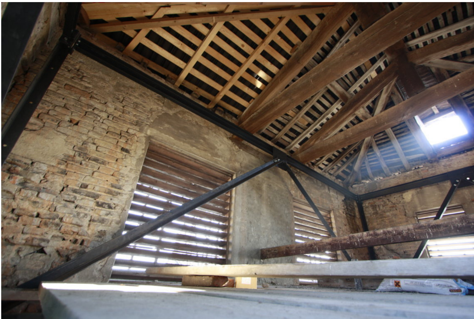
Il telaio metallico nell'attico della cella campanaria - Marzo 2014
