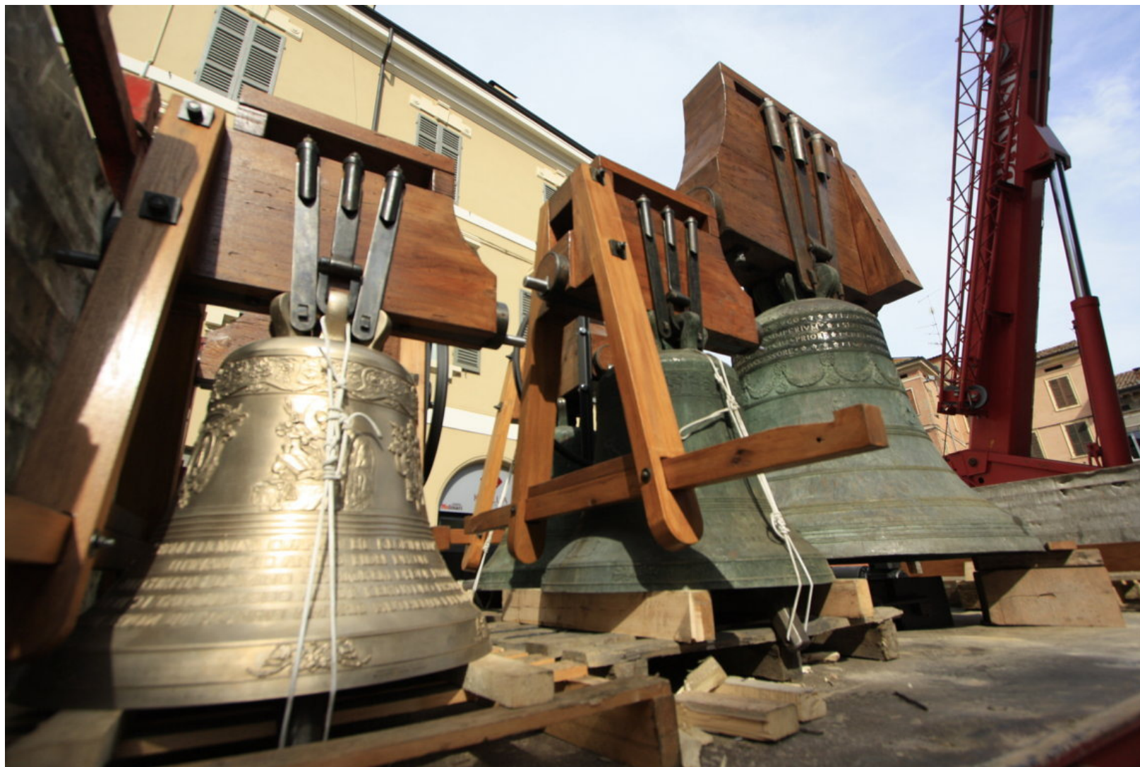
Operazioni di montaggio del concerto di Campane restaurato dalla ditta Capanni di Castelnuovo né Monti - Marzo 2014
