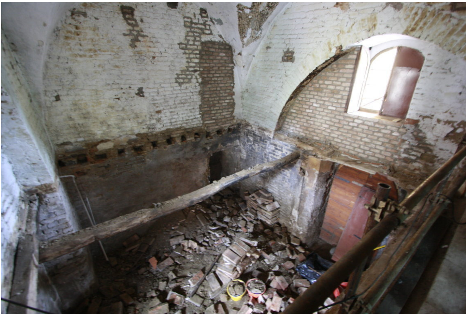
Demolizione piano ammezzato piè di Torre - Febbraio 2014
