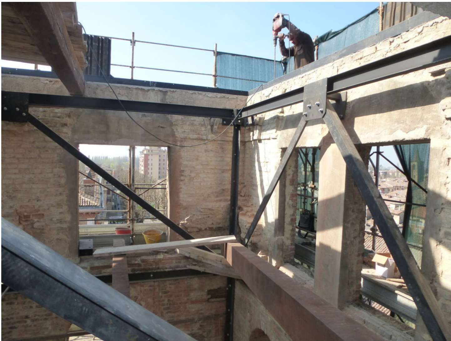
Fissaggio del cordolo metallico – ligneo di copertura - Marzo 2014
